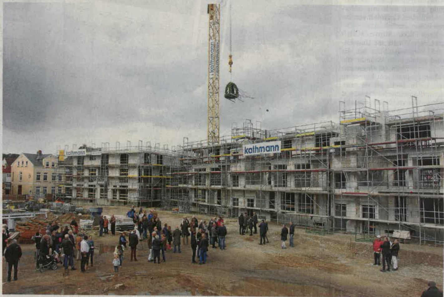
Zwei neue Mehrfamilienhäuser mit Eigentumswohnungen sind an der Hafenspitze im Rohbau fertiggestellt. Die zweigeschossigen Gebäude mit Staffelgeschoss sollen ab Ende März bezugsfertig sein.
