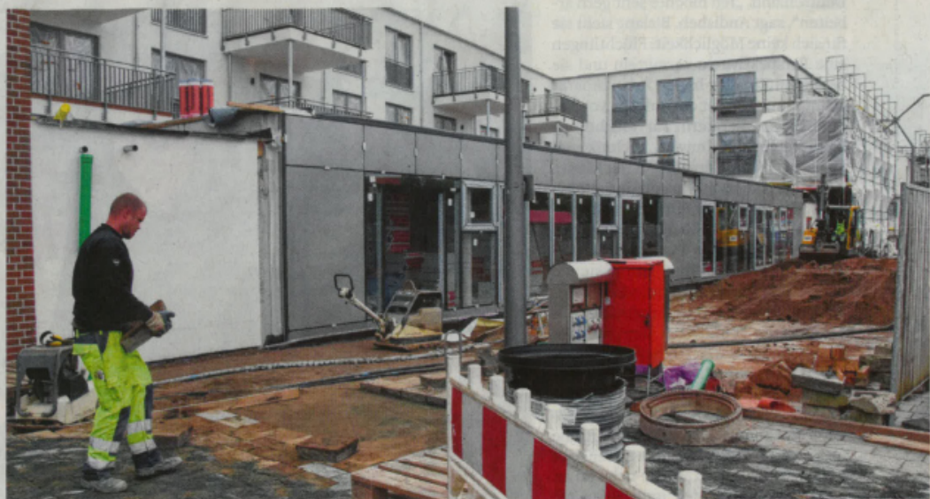
Der Bauzaun ist teilweise abgebaut und ermöglicht den Blick von der Hafenspromenade auf den Neubau. Davor wird zurzeit die Pflasterung der Hafenspromenade bis ans Gebäude herangelegt. In den Flachbau ziehen die Geschäfte Mehrfisch und Makoben ein. PETERS
